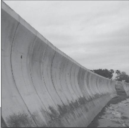
専用の大型水平積みブロックを積み上げるだけで、直立堤本体工が築造できるため、足場工、支保工、型枠工、鉄筋工を必要とせず、従来工法に比べて1/10という大幅な工期の短縮が図れる。これらの工種削減による単純施工や、プレキャスト製品によるセミプレハブ施工は、工期内での気象等の環境の急変にも迅速な対応が可能である。また、作業のほとんどを陸側の埋戻し材の上で行えることや、作業量の大幅な削減と単純化は、作業者の安全性を飛躍的に向上させる。さらに合板型枠やクギなどの廃材が一切発生しないため、海岸の環境保全にも寄与できる。
