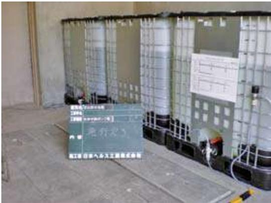
写真-8 薬剤添加装置設置状況① (地上1階 資材搬入口)
