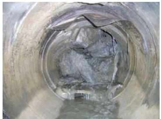
写真-4 秋津1号污水幹線閉塞状況（φ800）
