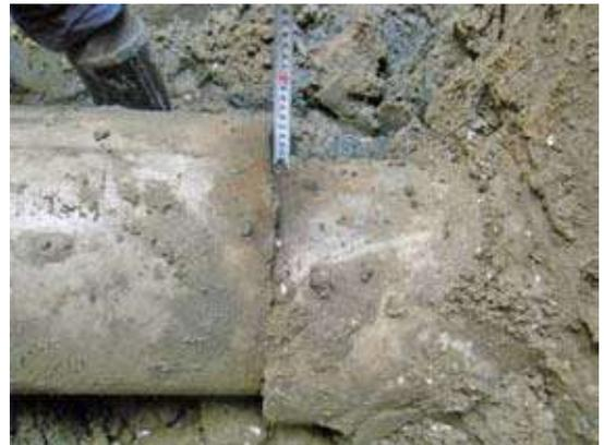
写真-3 袖ヶ浦地区（下水道管破断）
