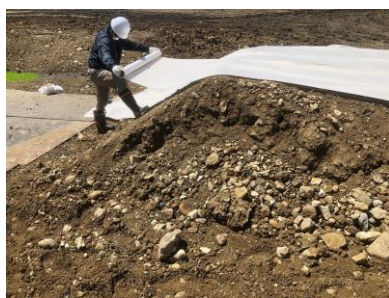
消臭シート敷設 ラップ幅を 50~100 mm
